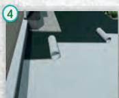
4 A gyomok feltörésének megelőzése érdekében fektessen le az egyenletes felületre geotextiliát.
